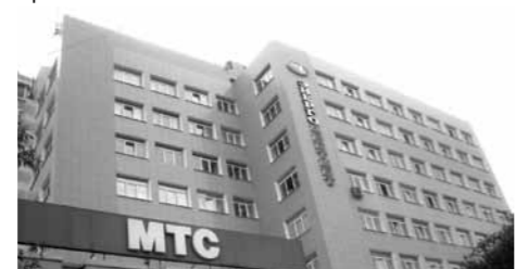
Административное здание МТС, «ЭНЕРГОЦВЕТМЕТ», Облицовка керамогранитом. ZIAS Optima
